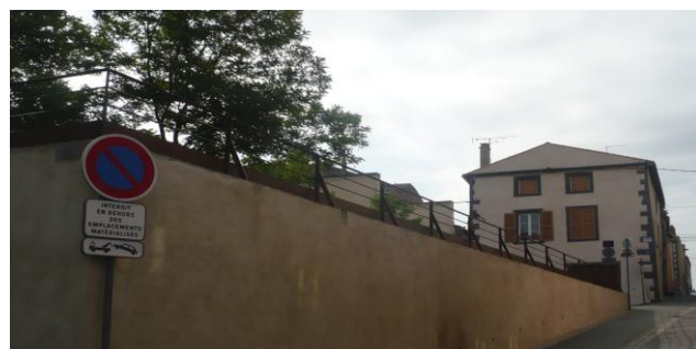
Place Poly, la nouvelle rambarde sécurisée
